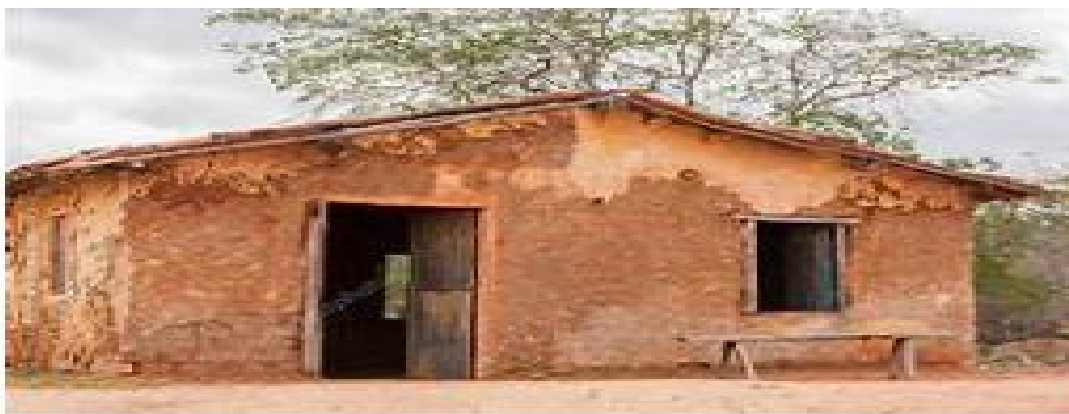
Figura 1 As casas de taipa são estruturas habitacionais construídas com a técnica ancestral de compactação de materiais naturais, como argila, areia, palha e água, para formar paredes, painéis e até mesmo tijolos.
